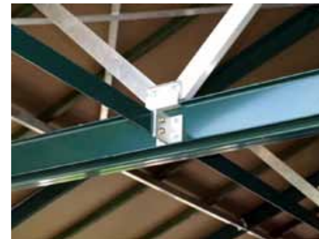
FOTO De bouw verwerkt veel gecoat en verzinkt materiaal, op zowel zichtbare als na oplevering onzichtbare plaatsen.
