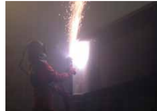
FOTO Met robuuste conserveersystemen zoals metalliseren kan een langere onderhoudstermijn verwezenlijkt worden, waarmee de hogere initiële kosten terugverdiend worden. Het scheelt bovendien in energie (stralen voor het overcoaten) en maatschappelijke kosten (files door wegvorming bij bruggen).
